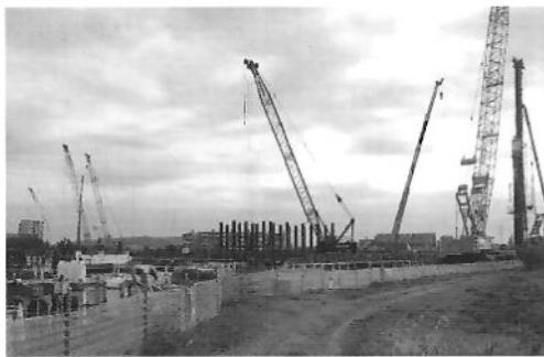
写真① 上牧・鶴殿ヨシ原で高速道路建設の工事が進む。右側のクレーンがヨシ原の中に建つ橋脚の基礎工事。左側のクレーンは対岸の工事。
