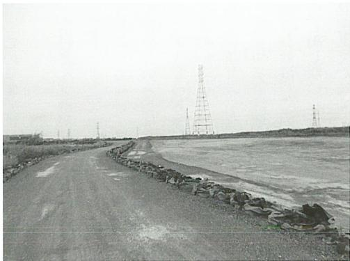
(写真4) 新設された工事用道路。写真2の(5)より下流を撮影。表土が土のうに入れられて道路の両脇に置かれている。(写真提供・NEXCO西日本)
